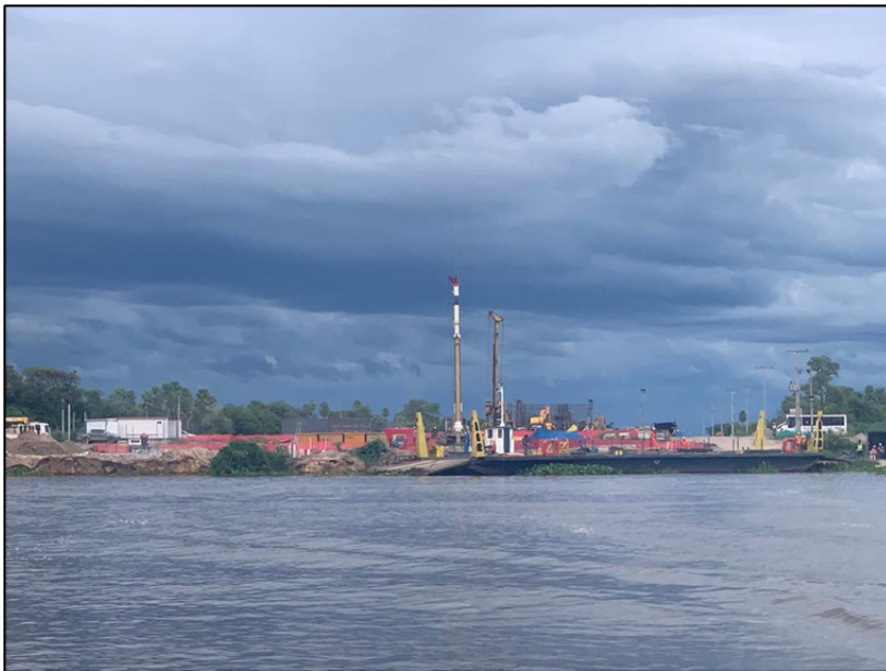
Figura 3. Obras en el Puente Binacional del lado paraguayo. Fuente: archivo personal del autor.
