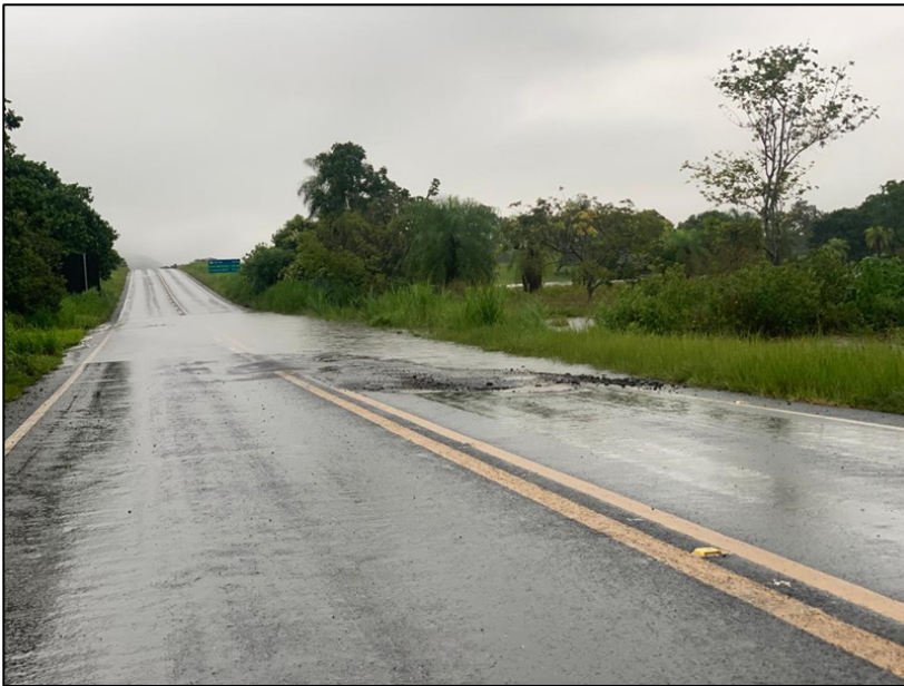
Figura 5. Carretera BR-267 que da acceso a la ciudad de Porto Murтинho/MS. Fuente: archivo personal del autor.
